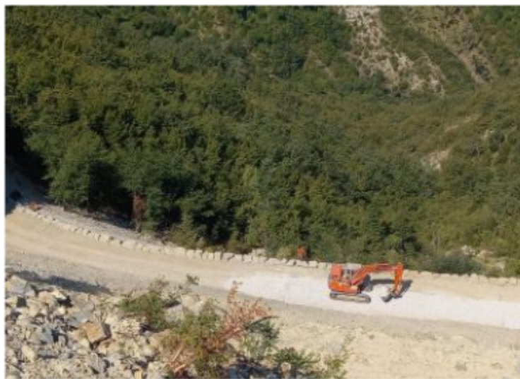
I lavori sulla strada della Valbura
